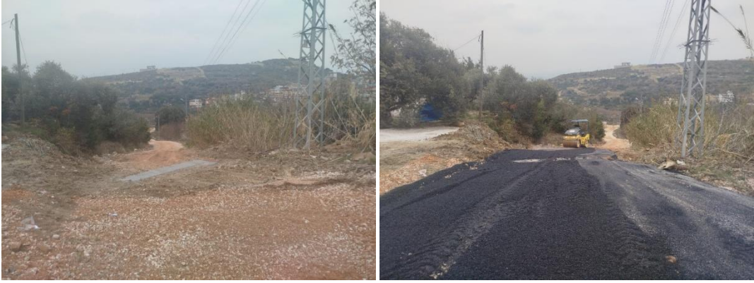
Dursunlu Mah. Yüzme Havuzu Yanı Asfalt Çalışması.
