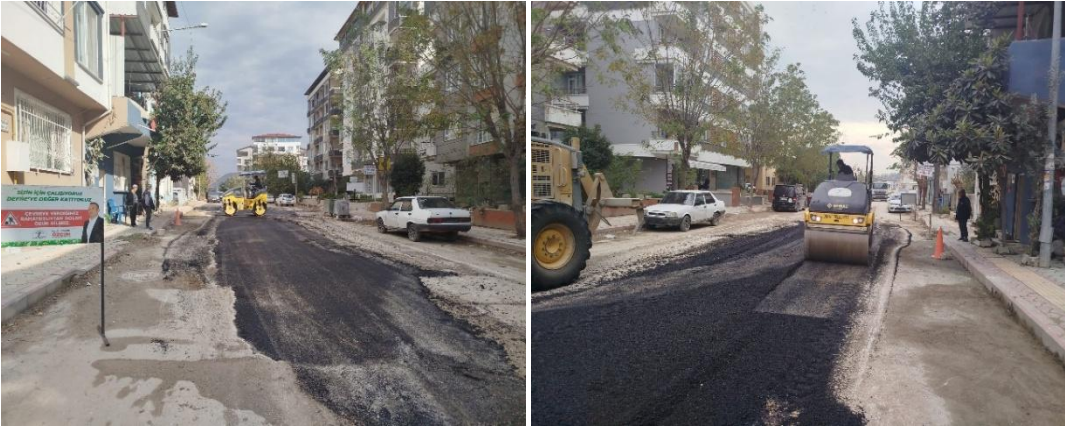
Armutlu Mah. Sağlık Ocağı yolu asfalt Çalışması.
