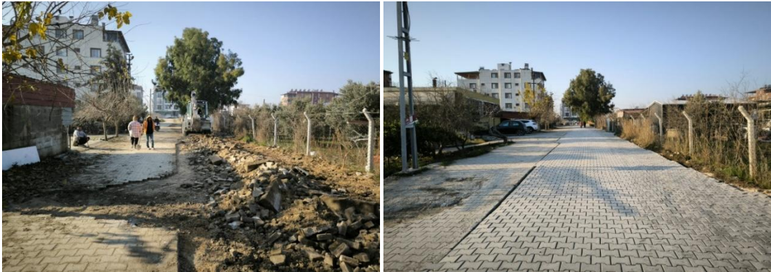
Çekmece Mah. 196. Sokak Parke Onarım Çalışması.
