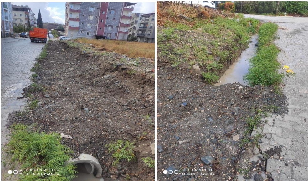
Büyükçat Mahallesi büz döşeme çalışması.
