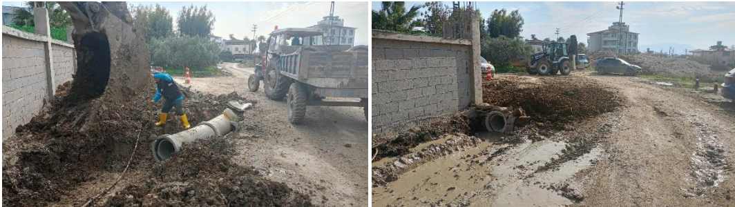
Çekmece Mahallesi 321. Sokak büz döşeme çalışması.
