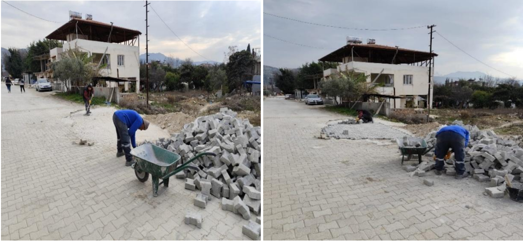
Tavla Mahallesi parke onarım çalışması.
