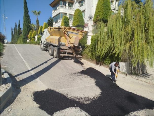
Bostancık Mah. Asfalt Yama Çalışması.
