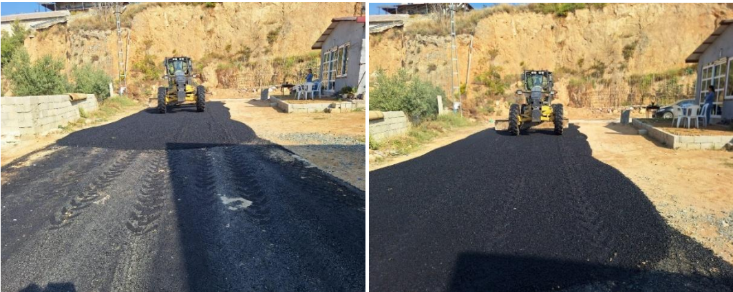
Yeşilpınar Mah. 5677. Sokak Asfalt Yama Çalışması.
