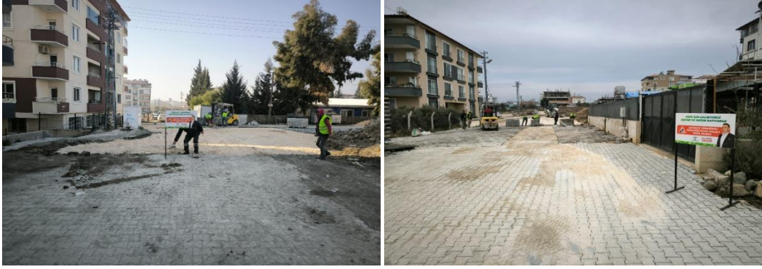
Çekmece Mahallesi parke yapım çalışması.
