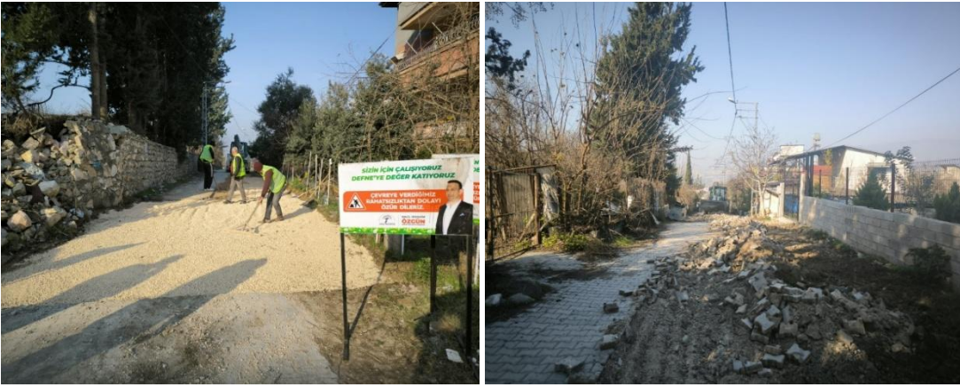
Harbiye Mahallesi Paşa Sokak Parke Onarım Çalışması.
