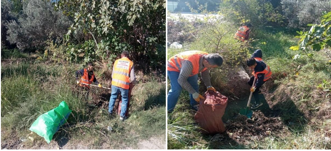
Tavla Mahallesi Kanal Temizleme Çalışması
