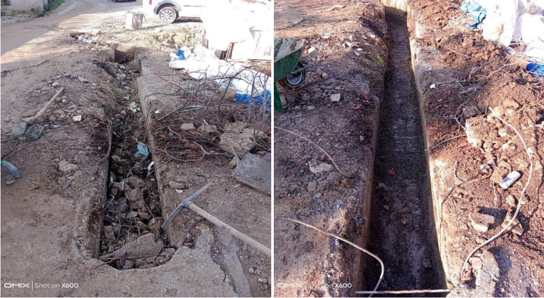
Sınlı Mah. Kanal Temizleme İşi.
