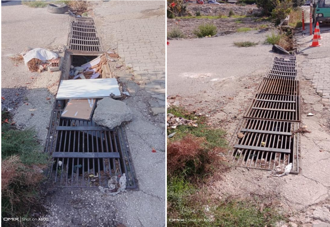
Sümerler Mah. Amfi Tiyatro Yanı Izgara Onarım Çalışması.
