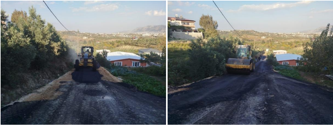
Koçören Mah. Mahalle İçi Asfalt Yapım İşi.
