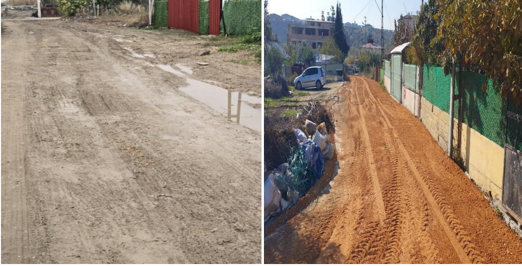
Çekmece Mahallesi 434. Sokak Stabilize Malzeme Serme Çalışması
