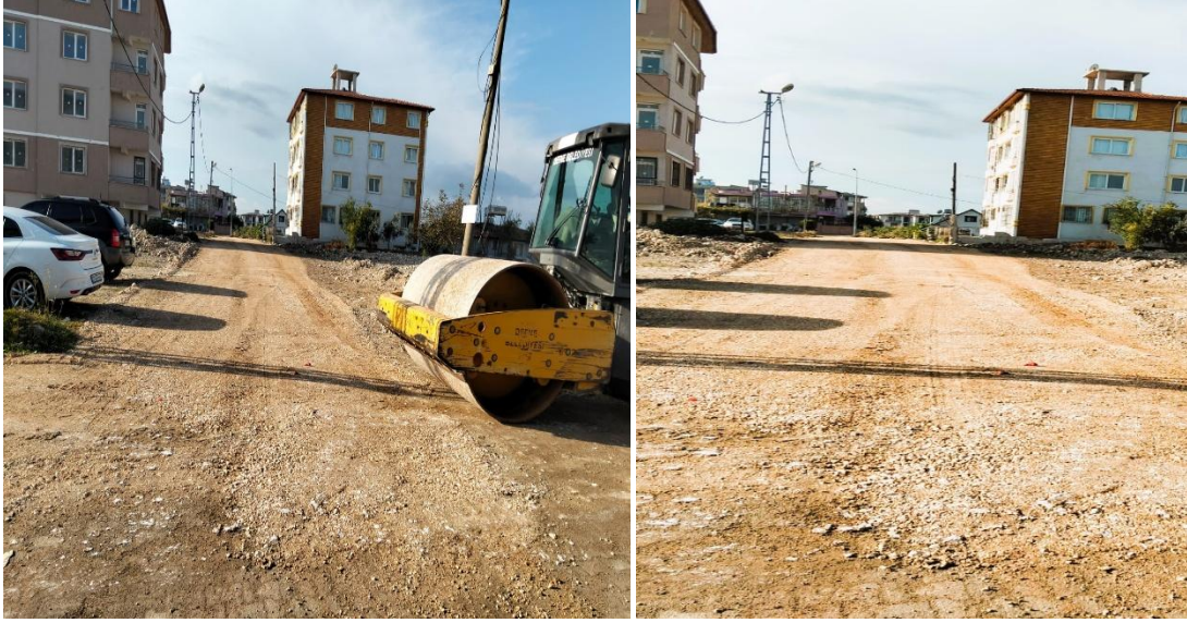
Çekmece Mah. 361. Sokak Stabilize Malzeme Serme Çalışması.
