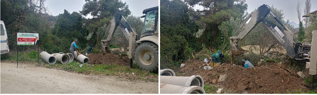
Toygarlı Mahallesi 8. Sokak büz döşeme çalışması.
