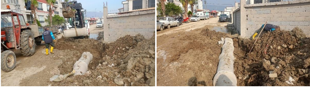
Çekmece Mahallesi 474. Sokak büz döşeme çalışması.
