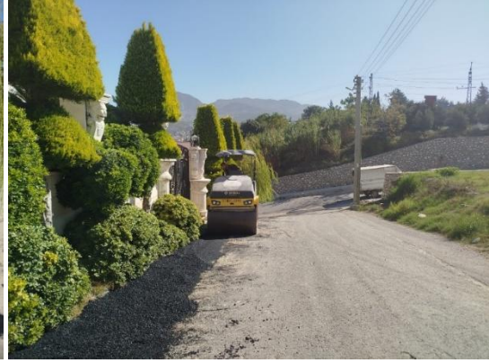
Bostancık Mah. Asfalt Yama Çalışması.
