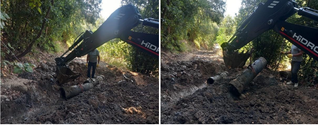
Harbiye Mahallesi Kule Restoran arkası büz döşeme çalışması.
