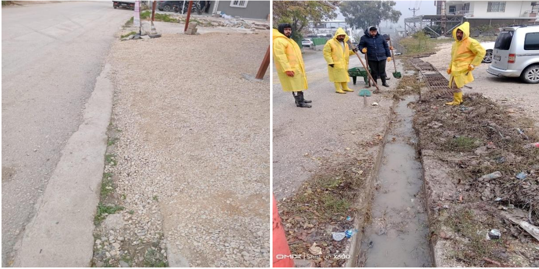
Balıklıdere Mahallesi Mahalle içi kanal temizleme çalışması.
