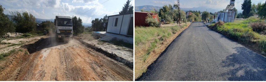
Güneysöğüt Mah. Asfalt Çalışması.
