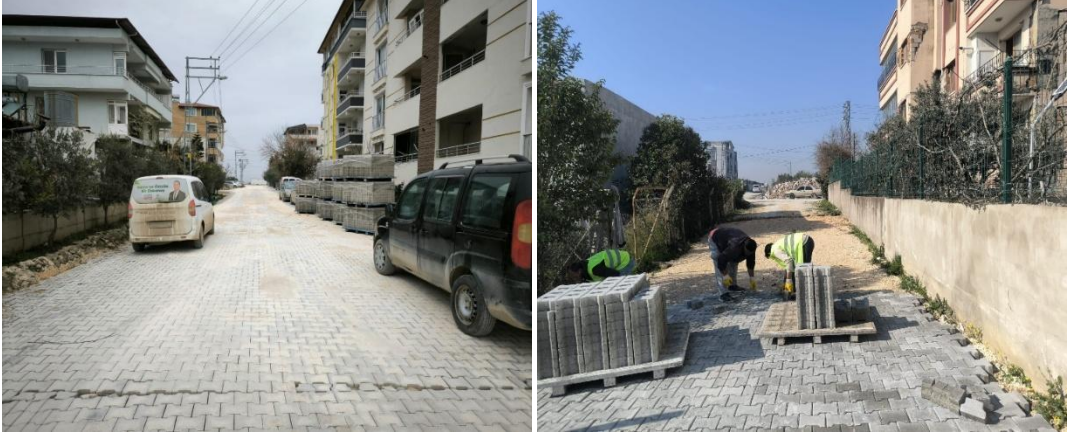
Tavla Mahallesi parke taşı yapım çalışması.
