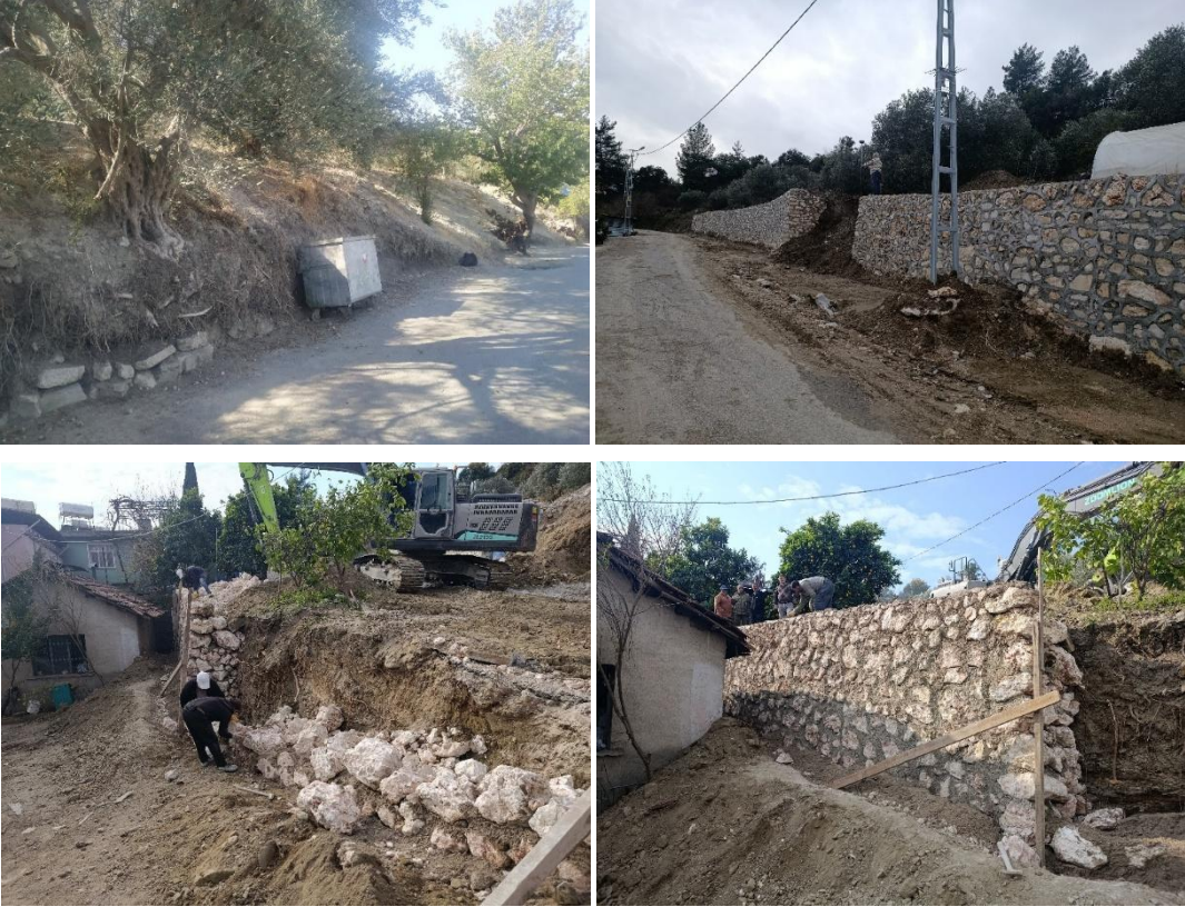
Çınarlı Mahallesi Köylü Sokak Taş Duvar Yapım Çalışması
