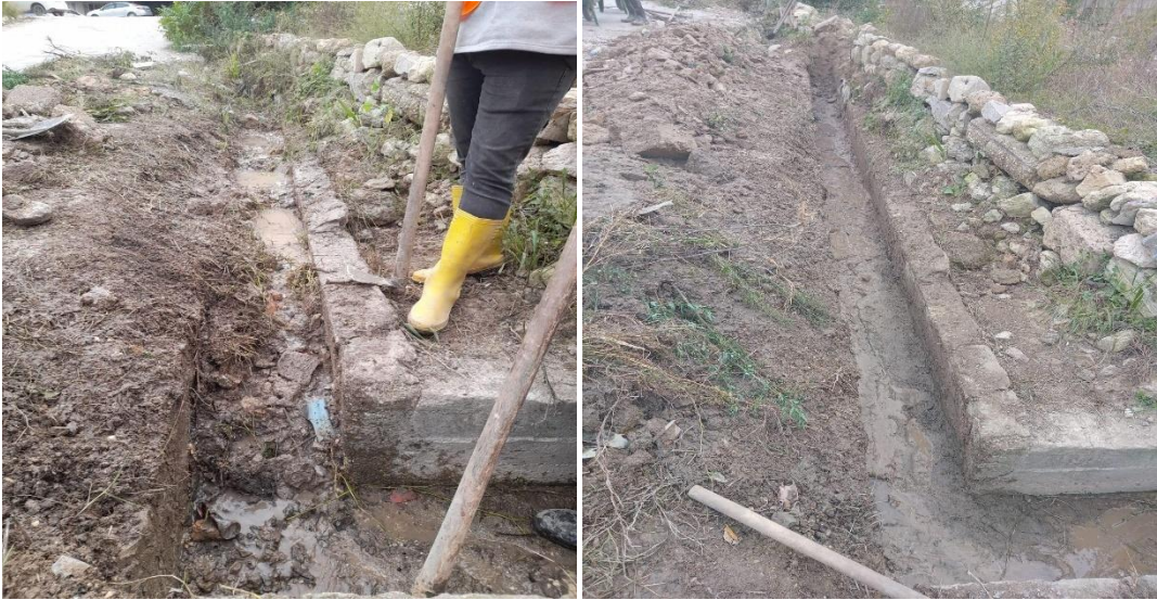
Samankaya Mahallesi kanal temizleme işi.
