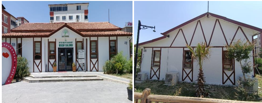
Çekmece Mahallesi Nikah Salonu
