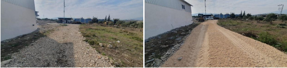
Yeniçağ Mah. 8024. Sokak stabilize malzeme serme çalışması.
