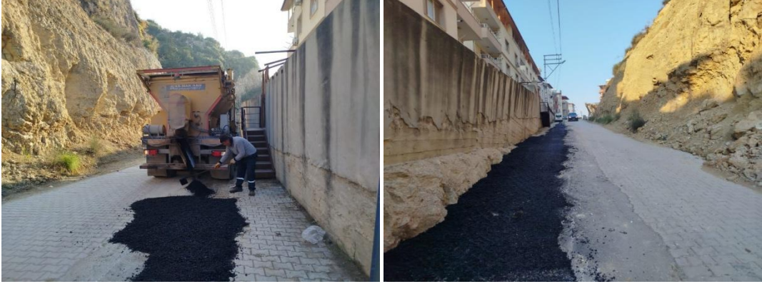
Dursunlu Mah. Yamaç Sokak Asfalt Yama Çalışması.
