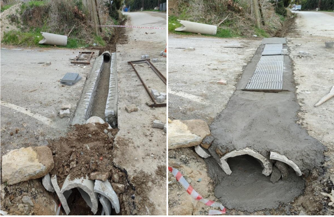
Ballıöz Mah. Okul Yolu İzgara Onarım Çalışması.
