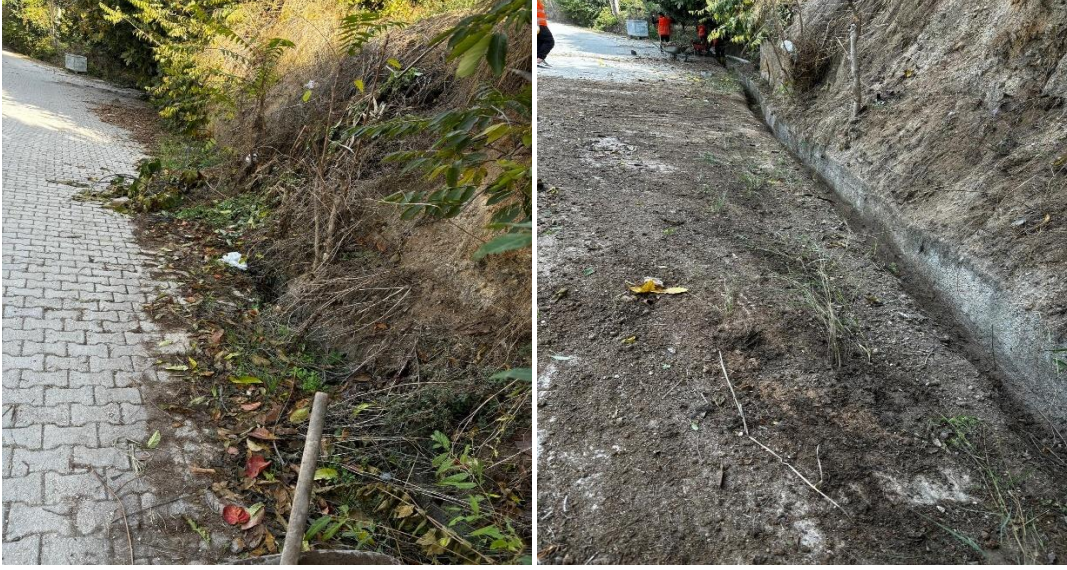
Harbiye Mahallesi kanal temizleme çalışması.
