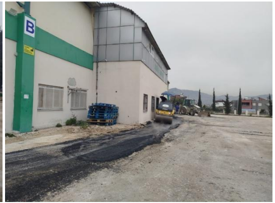
Çekmece Mah. Atatürk Stadyumu Önü Asfalt Yama İşi.
