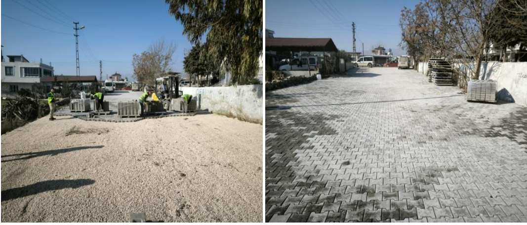
Çekmece Mahallesi 75. Yıl Okul Önü parke taşı yapım çalışması.
