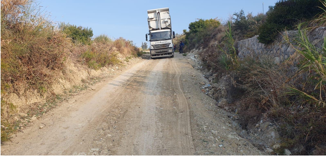
Dursunlu Mahallesi Bayrak Yolu Stabilize Malzeme Serme Çalışması.
