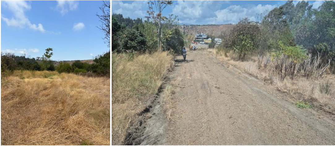
Aşağıokçular Mah. Mahalle İçi Yol Açma Çalışması.
