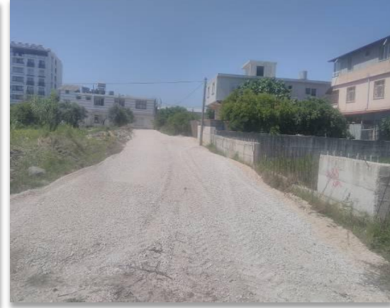
↓ Çekmece 117. Sokak (Bisiklet Yolu) Yol Açma ve Tesviye Çalışması
