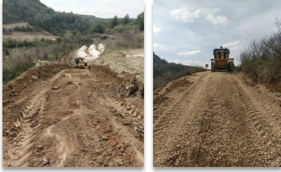
↓ Toygarlı Mahallesi Kot İndirme, Yol Tesviye ve Stabilize Çalışması
