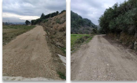
↓ Orhanlı Mahallesi Toygarlı Bağlantı Yolu Tesviye ve Stabilize Çalışması
