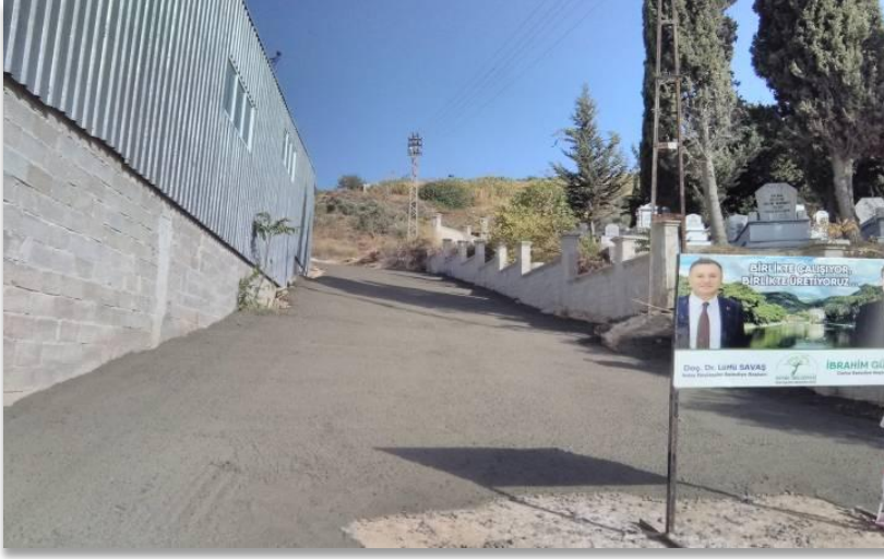
↓ Dursunlu Mahallesi Ana Yol Üzeri Yol Betonlama İşİ
