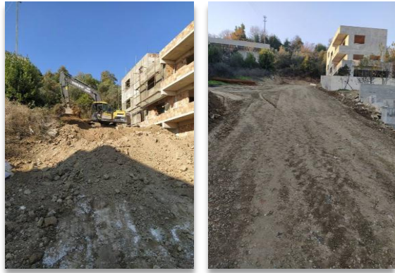
↓ Güneysöğüt Mahallesi Yol Tesviye ve Stabilize Çalışması
