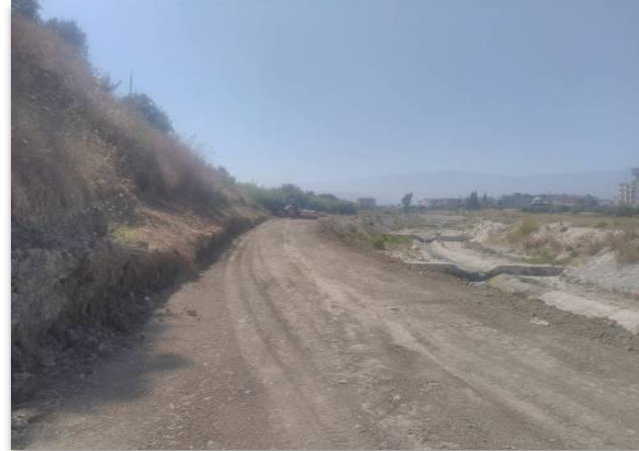
↓ Çekmece 117. Sokak (Bisiklet Yolu) Yol Açma ve Tesviye Çalışması
