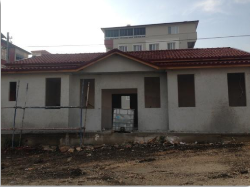
Çekmece (Yeşilkent) Semt Evi sıvası tamamlandı.
