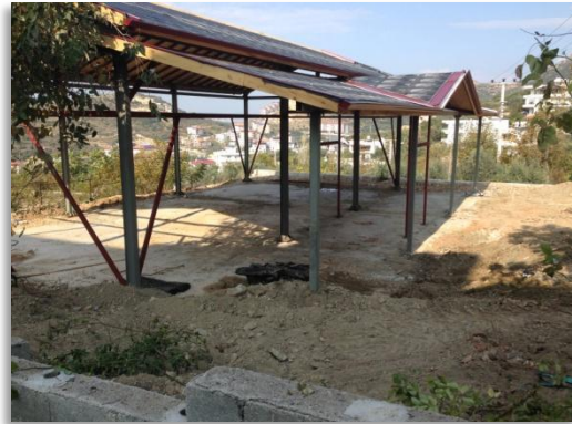
Dursunlu Semt Evi çatı yapım işi tamamlandı.
