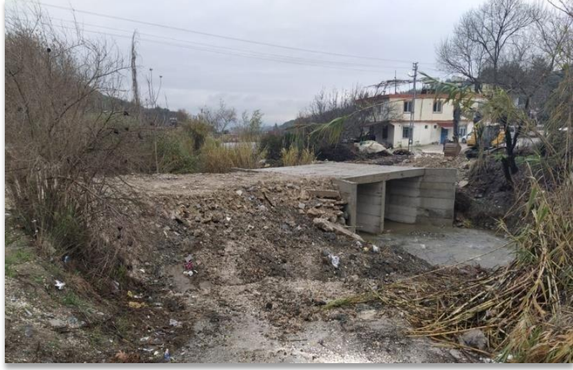
Çınarlı Mahallesi Kutu Menfez Yapım İşi
