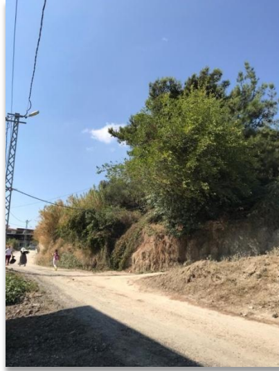
Toygarlı Mahallesi 8. Sokak Taş Duvar Yapım İşi
