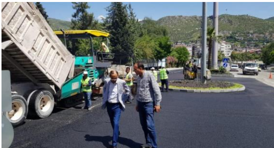
Asfalt Çalışmalarımız Devam Ediyor
