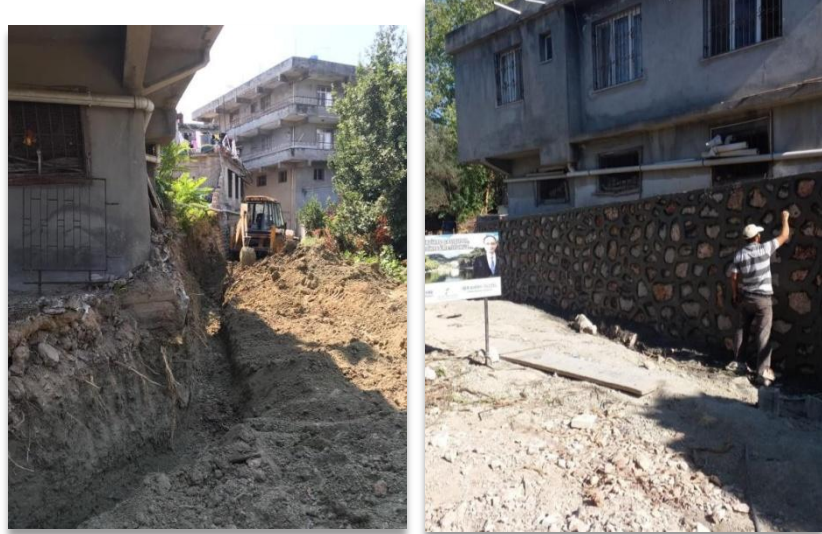
Gümüşgöze Mahallesi Defne Sokak Taş Duvar Yapım İşi
