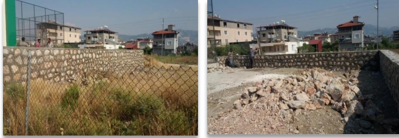
Çekmece Mahallesi Defne Atatürk Stadı Taş Duvar Yapım İşi
