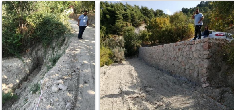
Sinanlı Mahallesi Dağ Yolu Taş Duvar Yapım İşi
