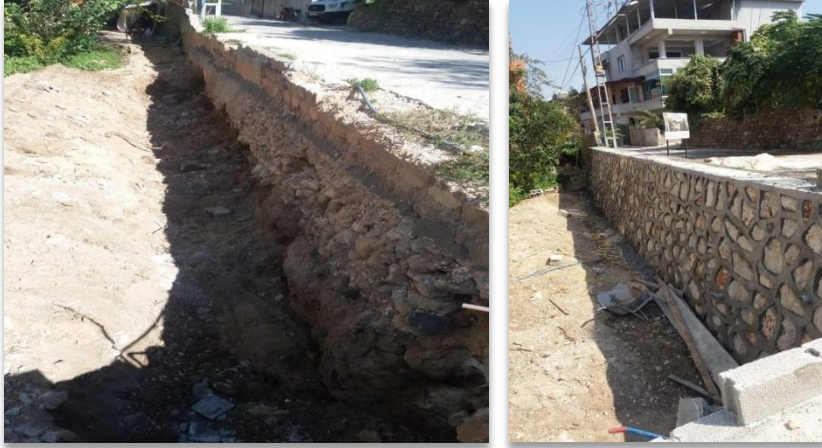
Gümüşgöze Mahallesi Bahar Sokak Taş Duvar Yapım İşi
