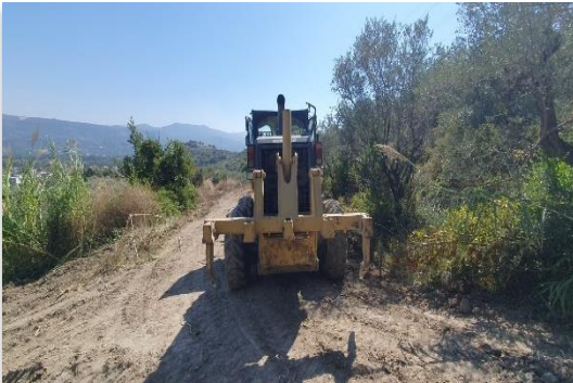
Hancağız Mah. Mezarlık Yolu Yol Açma Çalışması
