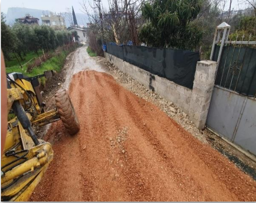
Değirmenyolu Mah. Çiftlik Cad. Malzeme Serme Çalışması
