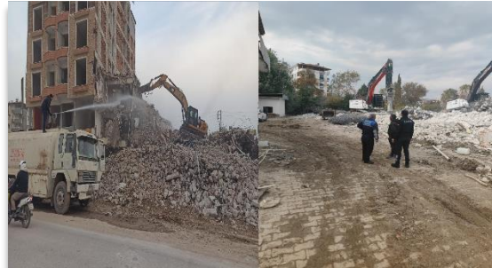
Yıkım çalışmalarında su kullanılmasının sağlanması
