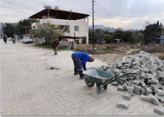
Harbiye Mahallesi Erler Cad. Parke Onarım Çalışması
