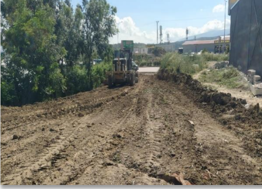
Subaşı Mah. Yol Açma/Kot İndirme Çalışması
