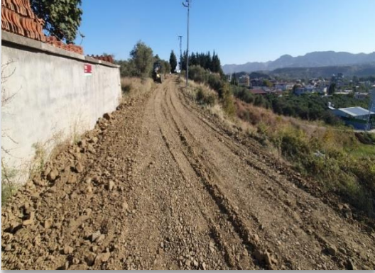
Orhanlı Mah. Kayrak Malzeme Serme Çalışması
