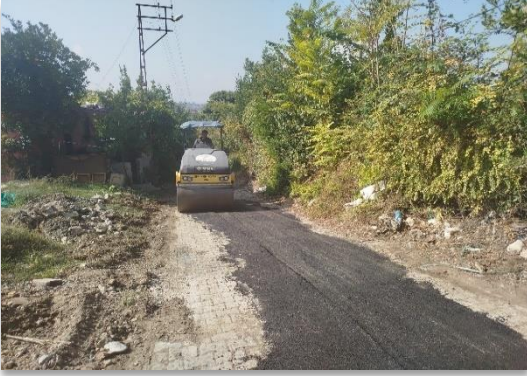
Harbiye Mah. Türbe Önü Asfalt Yama Çalışması.
