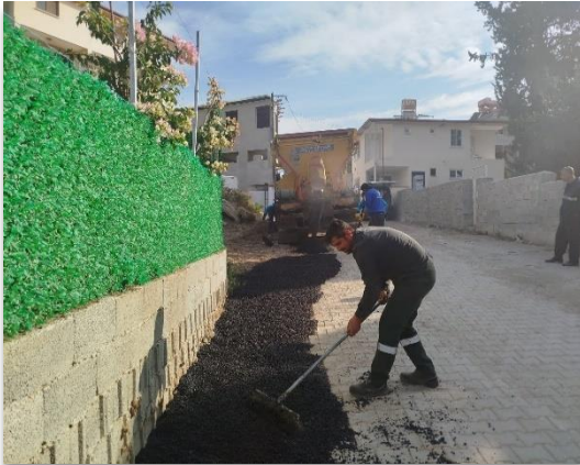
Gümüşgöze Mah. Cumhuriyet Cad. Asfalt Yama Çalışması.
