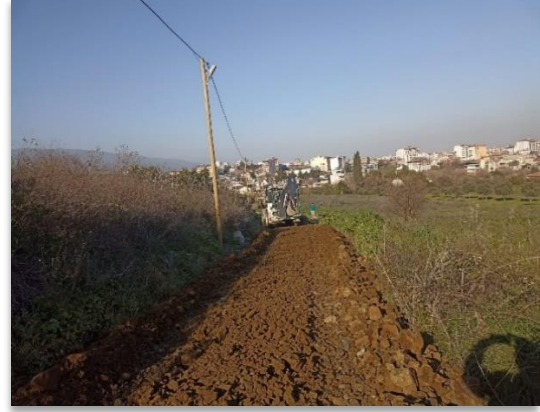
Çekmece Mah. Özdemir Düğün Salonu Cıvırı Kayrak Malzeme Serme Çalışması
