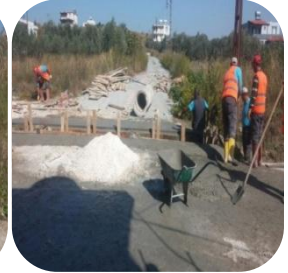
Kanal Açma Ve Izgara Yapımı
