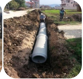
Kanal Açma ve Büz Döşeme
