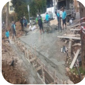
Hidro Park Kanal Açma Ve Izgara Yapımı
