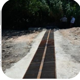
Kanal Açma Ve Izgara Yapımı
