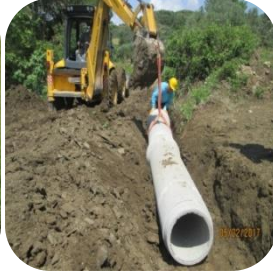
Kanal Açma ve Büz Döşeme
