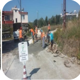
Kanal Açma Ve Izgara Yapımı
