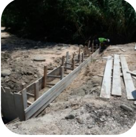
Kanal Açma Ve Izgara Yapımı
