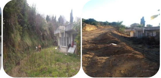
Yol Açma Çalışmaları
