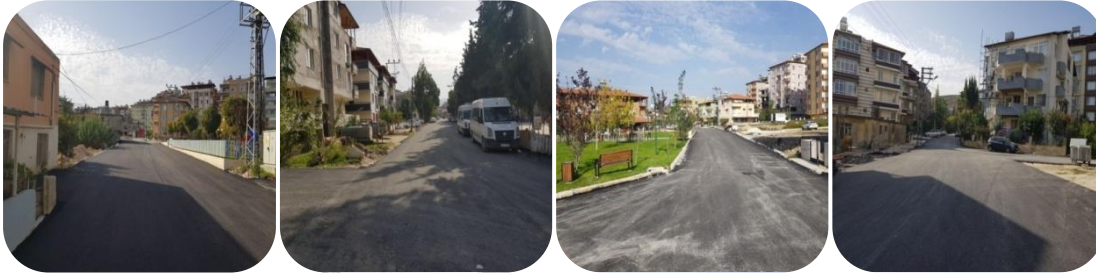
Aşağıokçular Mahallesi Güneyler Sokak
