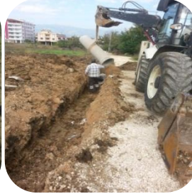
Kanal Açma ve Büz Döşeme
