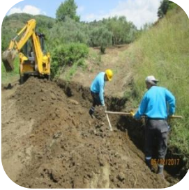
Kanal Açma ve Büz Döşeme
