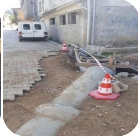
UğurMumcu Cad. Kanal Açma,Büz Döşeme
