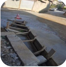
UğurMumcu Cad. Kanal Açma,Büz Döşeme
